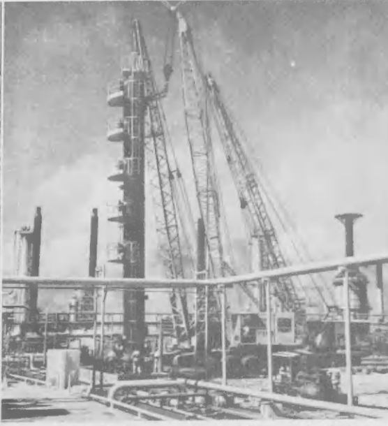
RIGGERS RECIENTEMENTE a pone tres grua di binti-cinco ton capacidad na trabao recientemente pa hiza e tower aki di cincuenta ton cual lo purifica feed gas pa e planta di amonia di A.C.C. E trabao tabata leuw for di rutina. E torre mester a worde lamtá mientras e ta equipá cu plataforma, trapi y cable.
